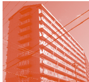
パシフィック美しが丘壺番街A棟
